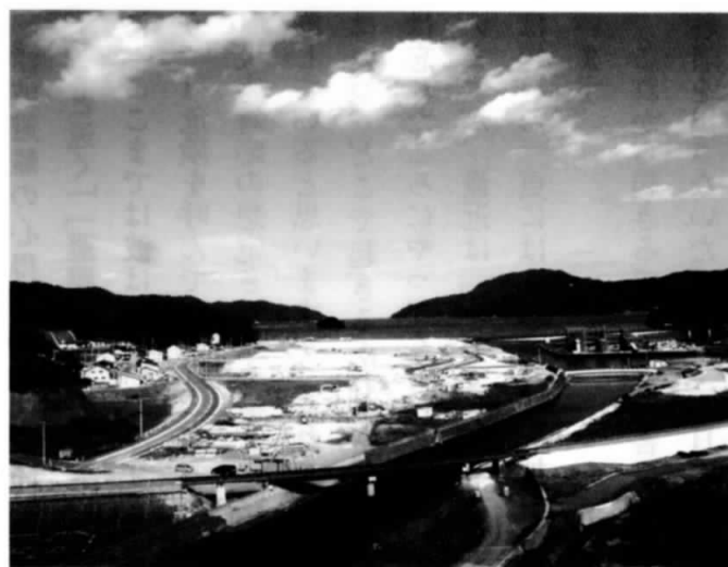
嵩上げ完了後
